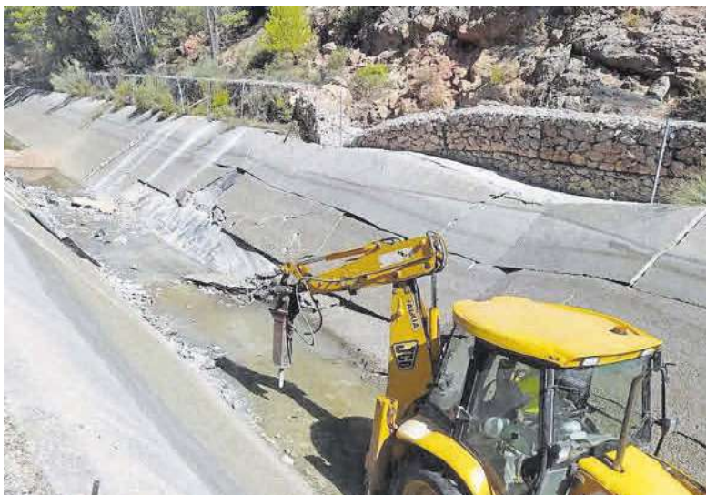
Obras de reparación del trasvase Tajo-Segura, en el tramo de Almonacid de Zorita (Guadalajara).
